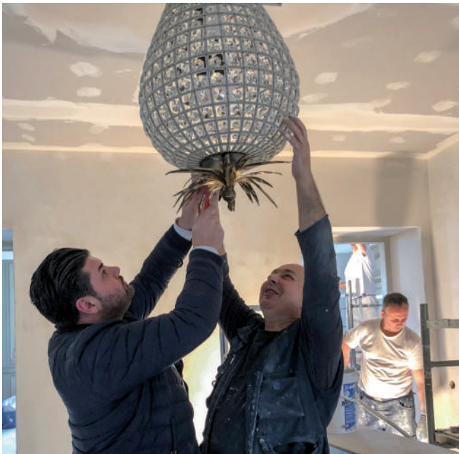
Rénovation Quai Gustave-Ador Genève, Suisse 2018 - 2019
