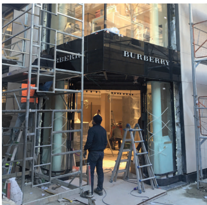
Burberry Rénovation Atelier Genève, Suisse 2017 - 2018
