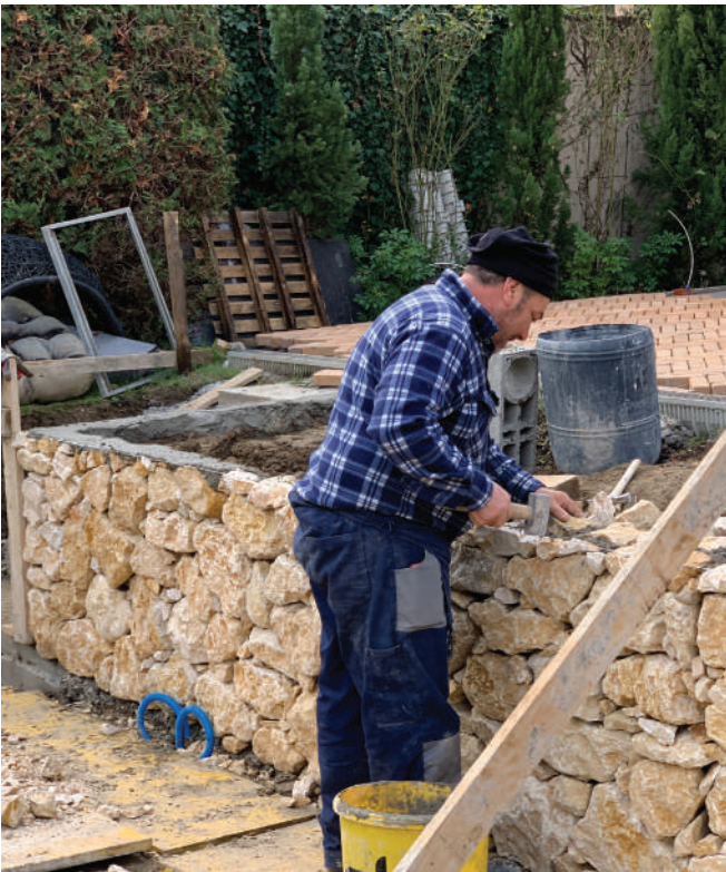
Rénovation Chemin du Molan 8 - Cologny 2019
